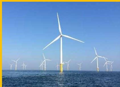
洋上風力発電の塔体部
